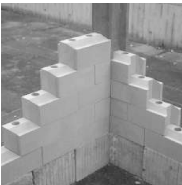
7-15 Sistema de bloques machihembrados FEB, 2001
