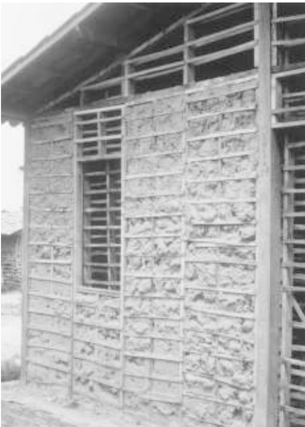
8-3 Bahareque con elementos prefabricados CEPED, Brasil
