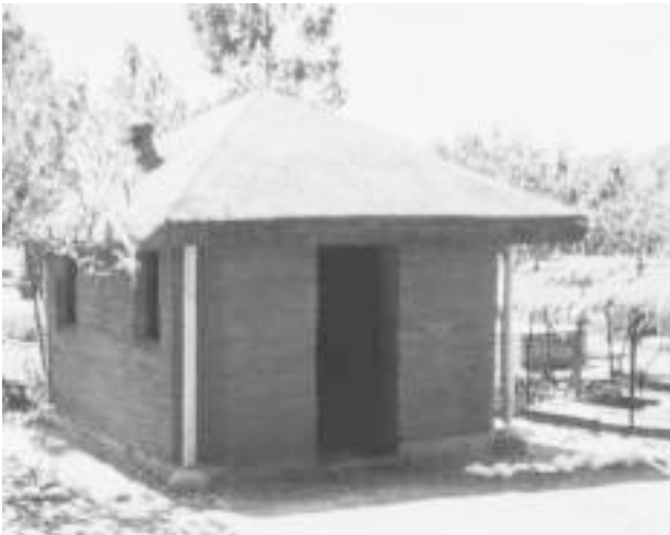
12-7 a 12-9 Vivienda antisísmica de bajo costo, Pujili, Ecuador 1989
