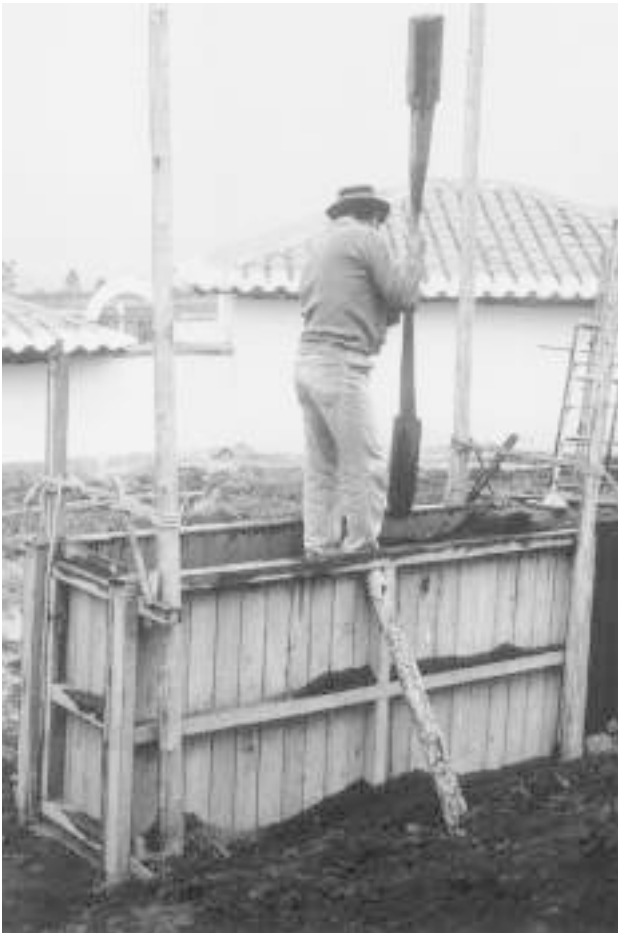
6-2 Pisón de dos cabezas empleado en Ecuador (Minke 2001)
