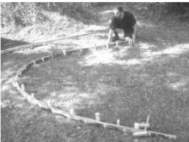
15-7 Construcción del arco de bambú
