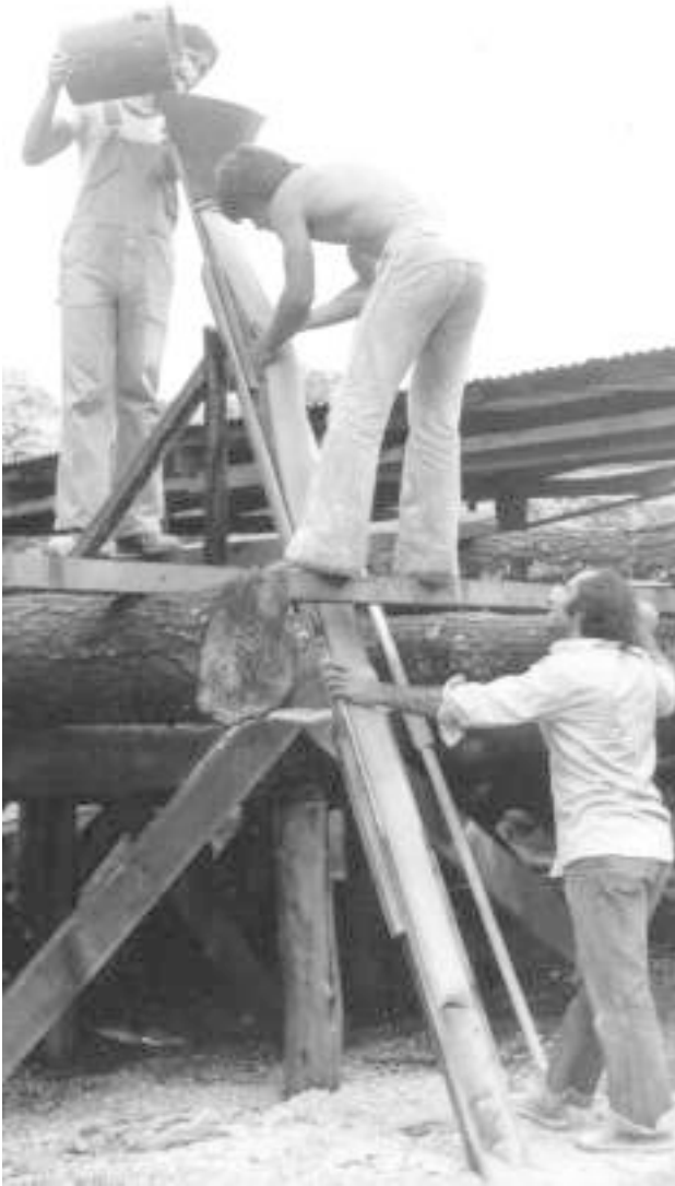
9-4 a 9-6 Proceso de construcción con mangueras textiles rellenas
