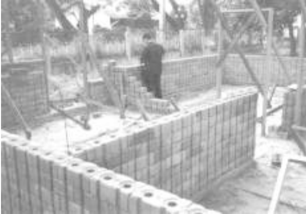
7-11 Bloques machihembrados (Weinhuber 1995)
