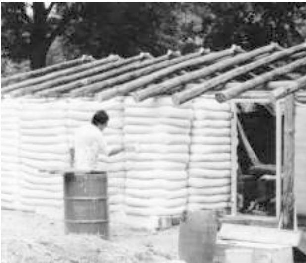
9-2 y 9-3 Muro de mangueras textiles rellenas
